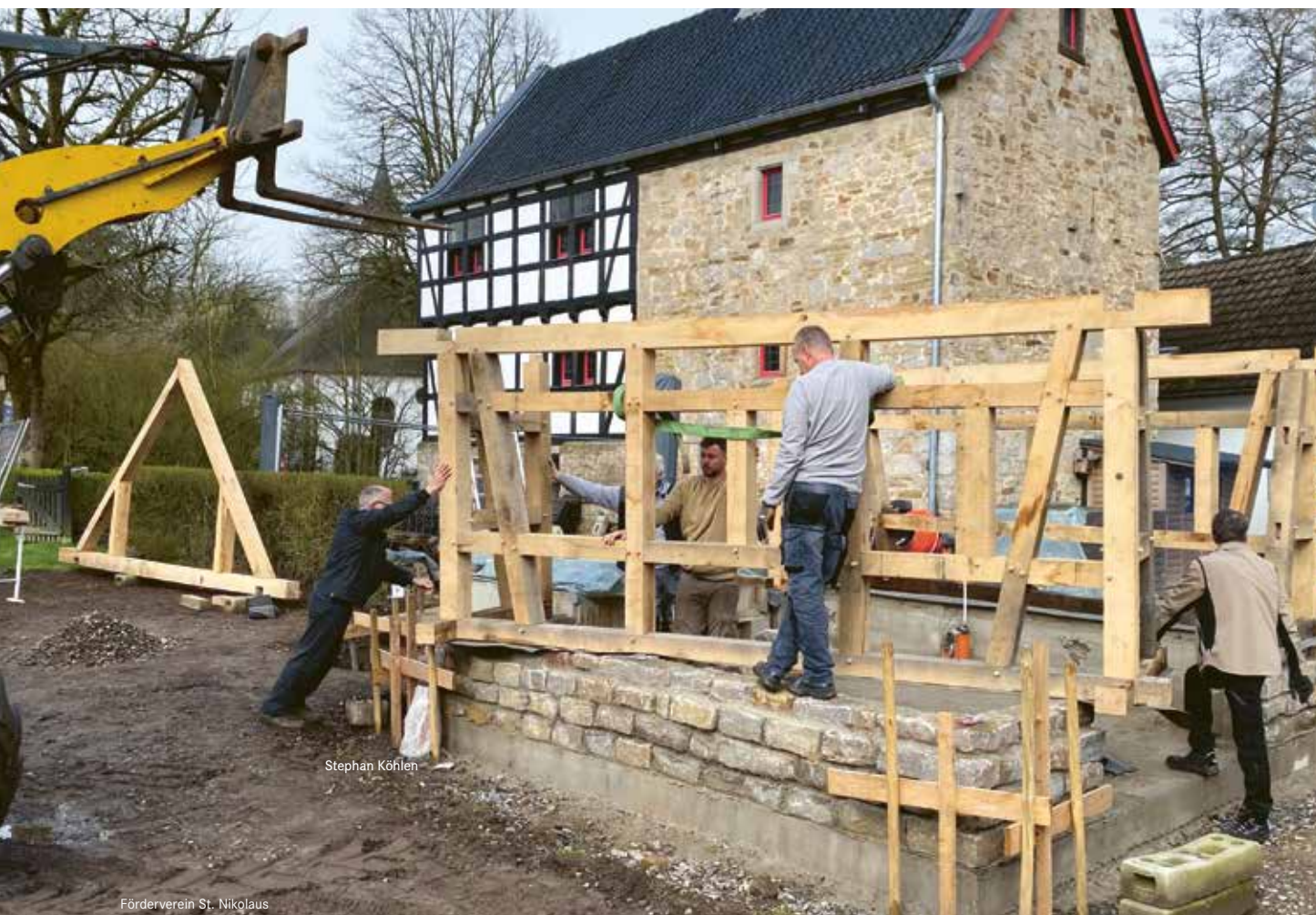
Das Fachwerk für das Backhaus wird errichtet. Das ehrenamtliche Bauteam mauerte die Gefache eigenhändig aus.
