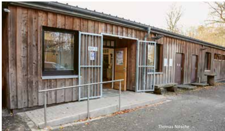
Eine flache Rampe vor dem Gebäude sorgt dafür, dass auch Menschen mit Behinderung leichter ins Waldlabor kommen.
