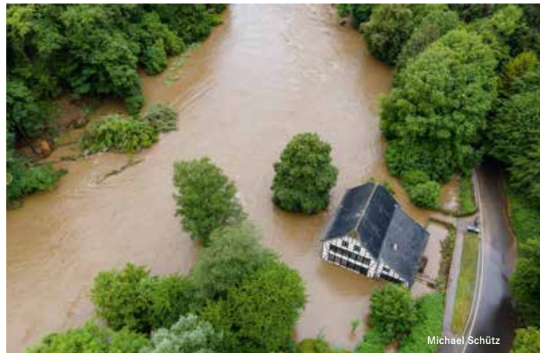
Unmittelbar nach der Flut stand der historische Balkhauser Kotten in Solingen unter Wasser.
